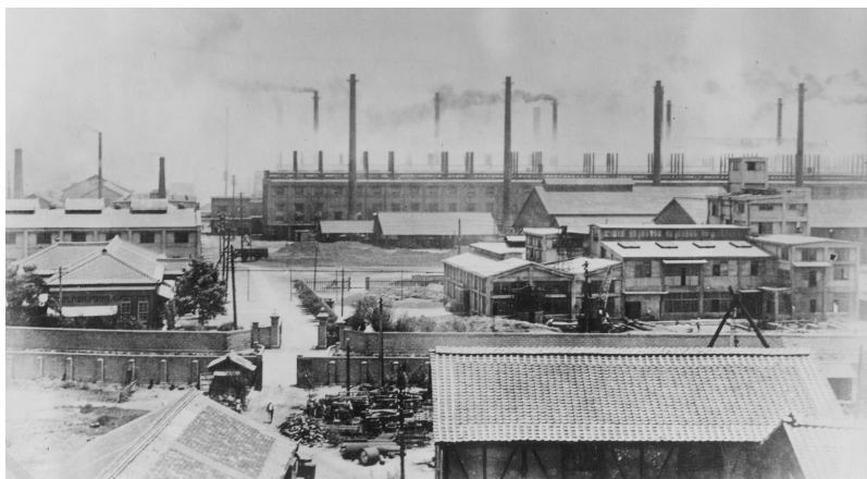
三池製煉所全景（昭和2年6月）
